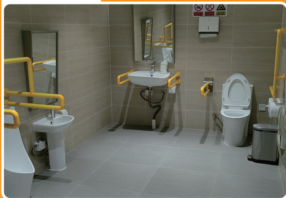
黄木岗地铁站无障碍卫生间
