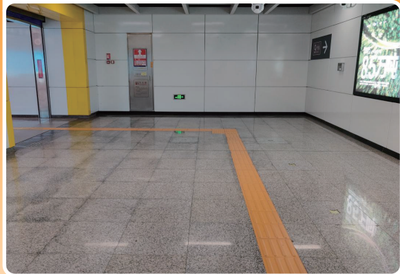
少年宫地铁站内盲道
